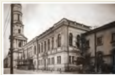
Історична будівля ЦНБ ХНУ імені В.Н. Каразіна (вул. Університетська, 23)
