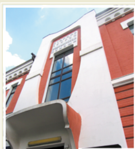
Здание ССМП в Харькове, ул. Конторская, 41
