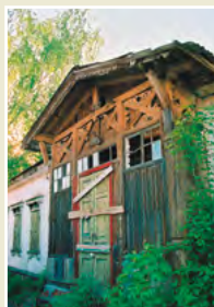
Фасад садибного будинку Щербініних після перебудов
